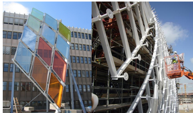
Abbildung 2: Yas Island Hotel. Links: Testaufbau am Werksgelände von Waagner-Biro Stahlbau, Wien. Rechts: Montage.
