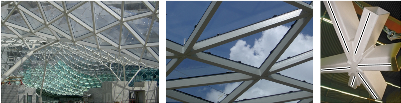
Abbildung 8: Links: Złote Tarasy, Warschau (Design Jerde Partnership International, Ausführung Waagner-Biro Stahlbau). Stahl-Glas-Konstruktion, die einem Dreiecksnetz folgt. Mitte: Detailansicht. Rechts: Ein Knoten, der mehrere Träger verbindet, wird aus Trägerteilen und einem zentralen durch Plasmaschneiden aus einer dicken Stahlplatte erzeugten Stück vorgefertigt. Man kann deutlich erkennen, dass die Symmetrieebenen der an dem Knoten beteiligten Träger keine eindeutige Knotenachse definieren (d.h. der Knoten ist nicht torsionsfrei).
